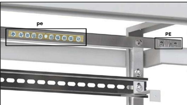
Обозначения: PE - место крепления магистрального кабеля заземления, pe - место крепления кабелей отходящие в квартиры (где 1-8 количество квартир).
